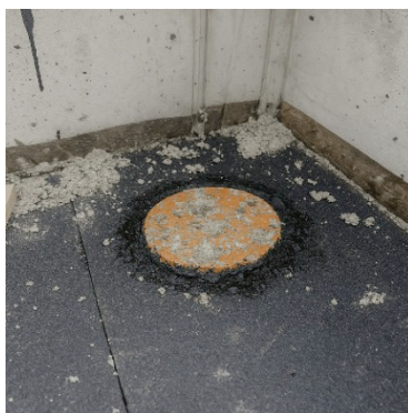
Рисунок 2 Герметизация раструба трубы вровень с плитой перекрытия гидроизоляционным составом (герметиком)
