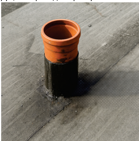
Рисунок 3 Нанесение битума на вертикальную трубу
